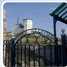
Ganolfan Ymwelwyr Visitor Centre
